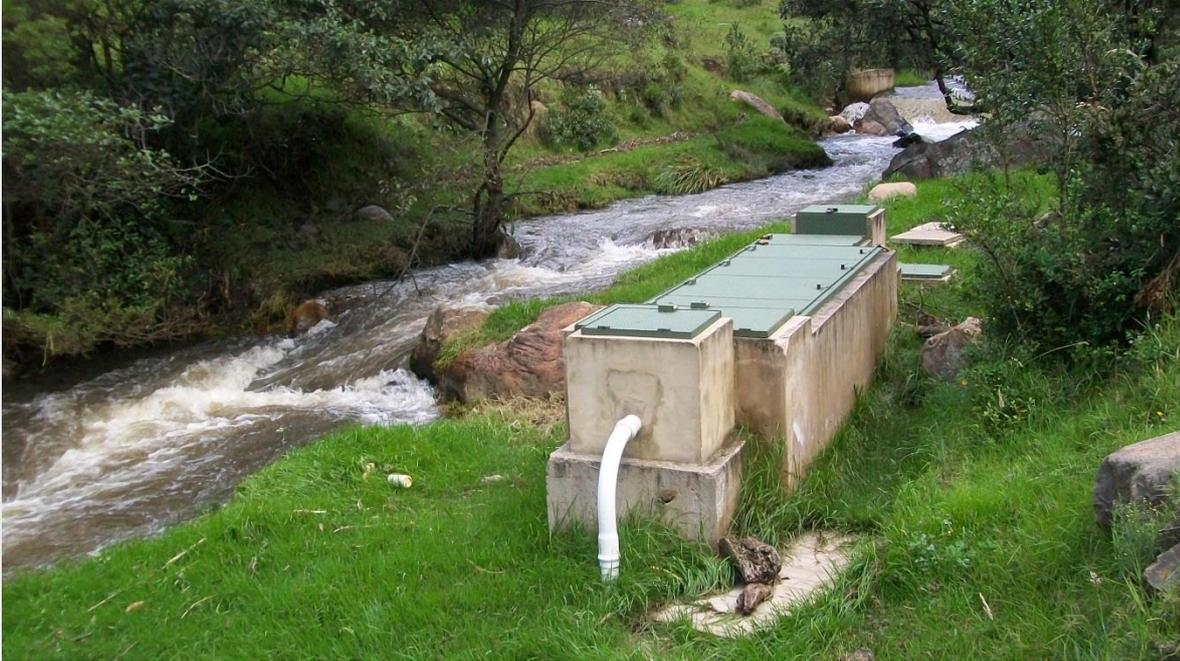
El proceso de pretratamiento del agua consiste en la remoción del material flotante por medio de un proceso de sedimentación efectuado por un desarenador, que cumple la función de sedimentar partículas en suspensión por la acción de la gravedad.
